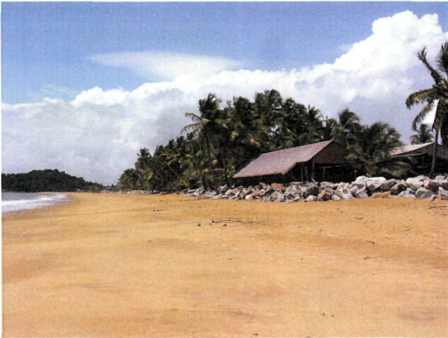
Figure 46 - Enrochement sur la plage de Montoly (M.Moisan, 2011)
