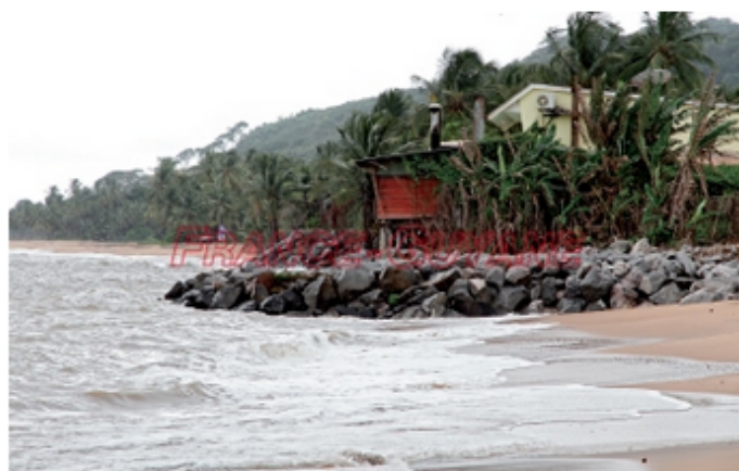
Après les grandes marées de décembre, un nouvel enrochement s'est avéré indispensable pour protéger l'Auberge des plages (Jody Amiet & ASM)
