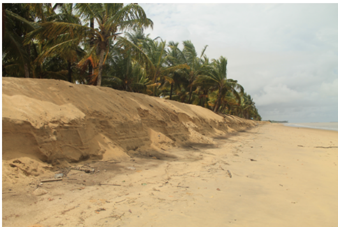
Figure 5.12 : Affouillements du cordon sableux, en novembre 2017 (cliché Louis Portier, 2017)
