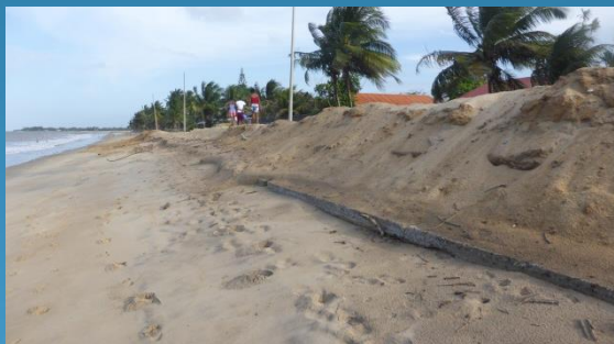
Désordres / érosions du cordon sableux constitué à Kourou (Aout 2016 – ARTELIA)
