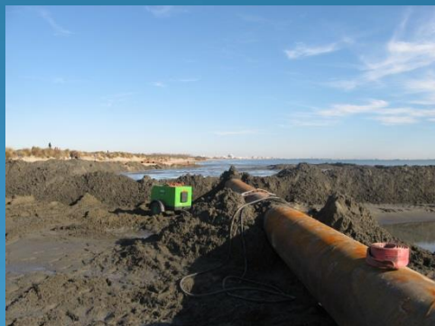
Refoulement de sable sur une plage (ARTELIA)
