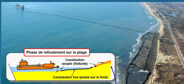
Rechargement par conduite de refoulement (ARTELIA)
