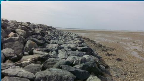
Enrochement à Chatellaillon-Plage (photographie ARTELIA 2015)
