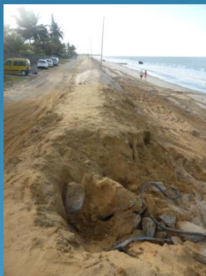
Désordres / érosions du cordon sableux constitué à Kourou (Aout 2016 – ARTELIA)
