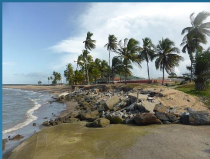
Ruine de l'enrochement de l'hotel des Roches – Kourou (photo Aout 2016)
