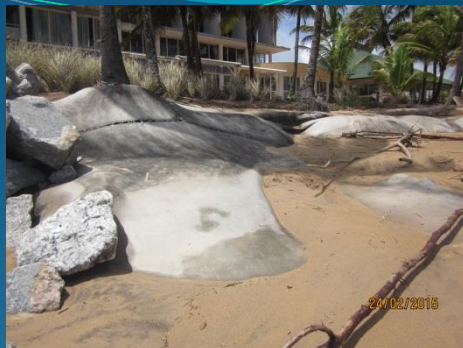
Protection géotextile à l'hôtel des roches à Kourou (photo DEAL)
