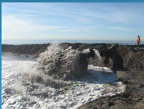
Refoulement de sable sur une plage (ARTELIA)
