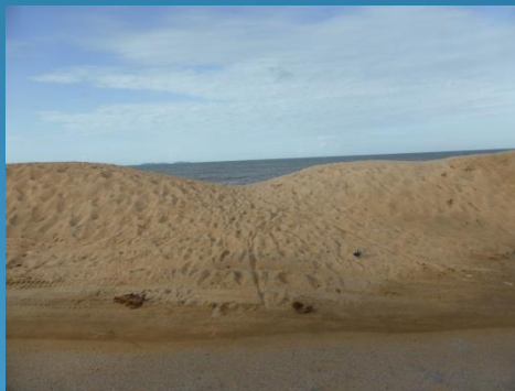
Affaiblissement du cordon sableux à Kourou du fait de la non gestion de la fréquentation (phot Aout 2016 – ARTELIA)
